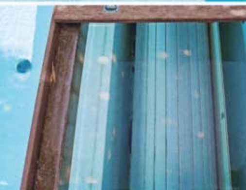
Die Holzdielen an der Stirnseite des Beckens können hochgeklappt werden. Dies ermöglicht einen direkten Zugriff auf den Rollladenschacht.
